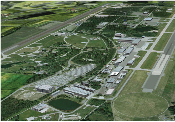
Abbildung 9: Beispiel Airport Manching
