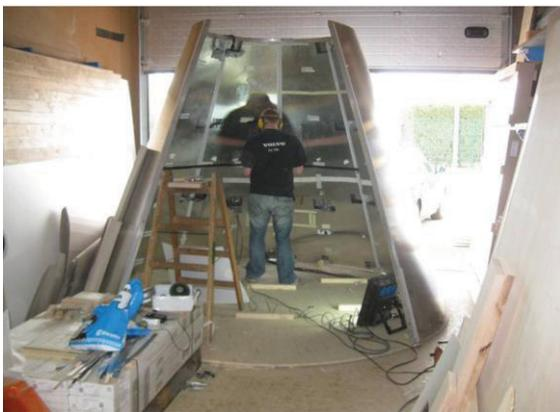
**Bild 15:** Aluminiumhülle des Mock Up
