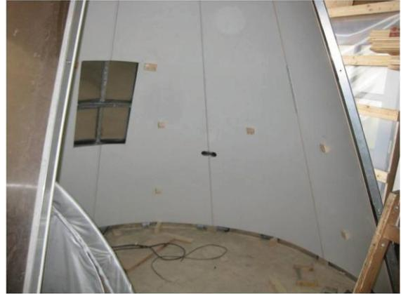
**Bild 16:** Verschalung der Wände
