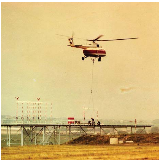
BILD 15 – Hubschraubermontage, [8]
